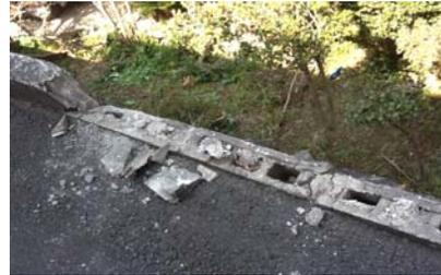
準市道には防護柵など設置されておらず、雨よけのブロックが2段詰まれているだけで鉄筋も入っていませんでした。3m下
