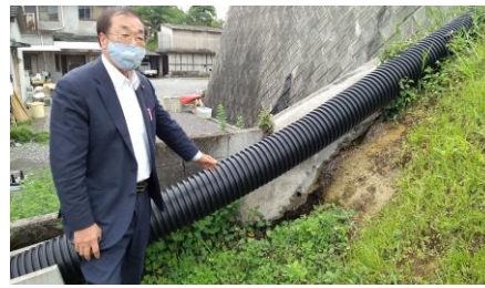
(漏水調査する福間)
