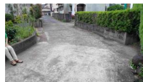
(羽屋・下水道敷設を)
