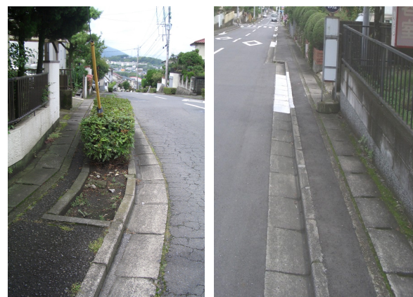
改修された歩道（右）
